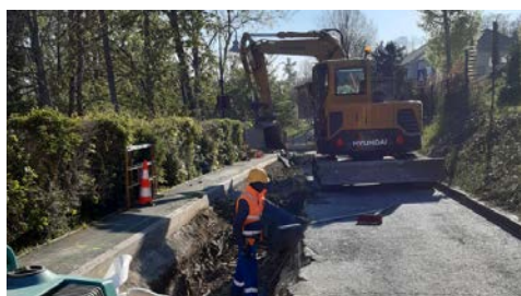
Travaux de voirie
