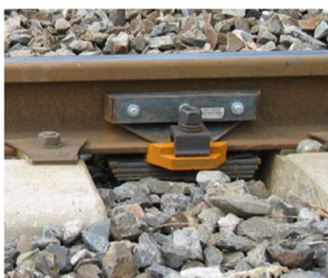
Absorbeur de vibrations sur rail (source SNCF)
